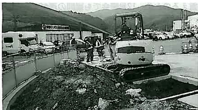
2月にバス停オープン。工事が進む
