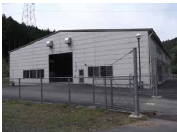
【鹿野一般廃棄物最終処分場】
