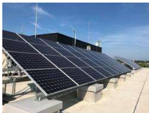
【市役所本庁舎の太陽光発電設備】
