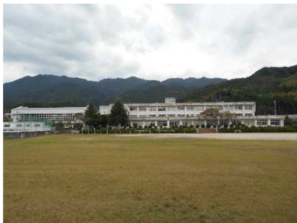
【高水小(外壁・防水)】
