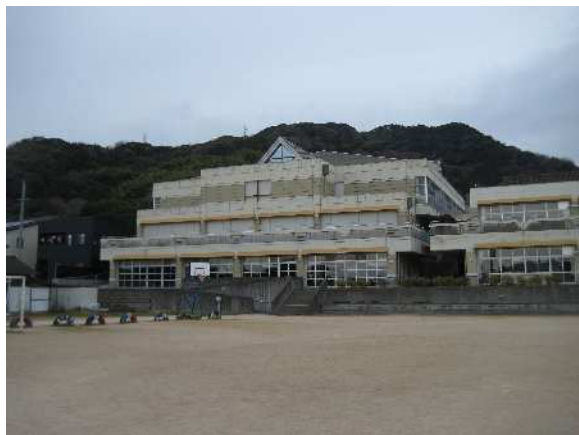
【富田西小屋体防水改修】
