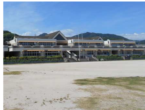
【富田西小(外壁・防水)】
