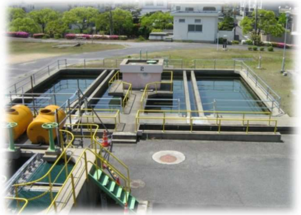
〔高速凝集沈澱池〕
