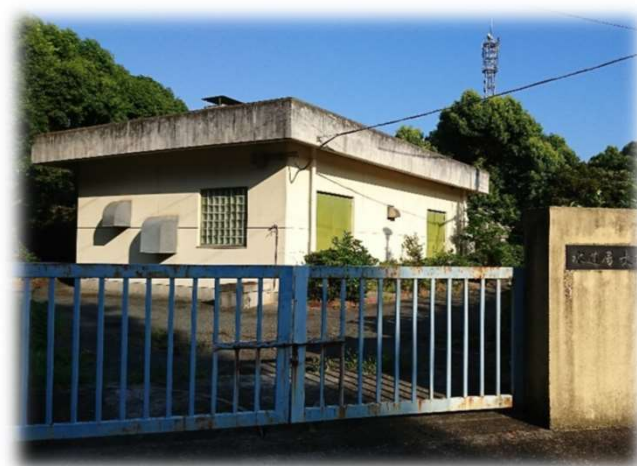
〔長田団地ポンプ所（休止中）〕
