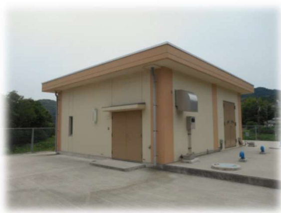
〔ポンプ場（熊毛送水）〕
