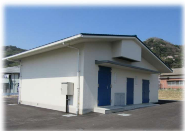
〔北山加圧ポンプ所〕
