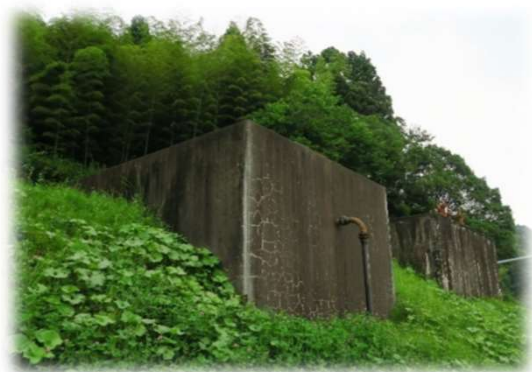
[第1 須々万配水池]
