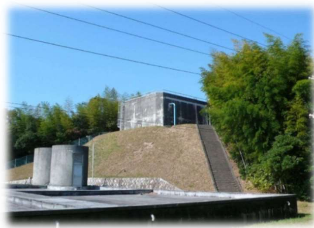
[大迫田高地区配水池]
