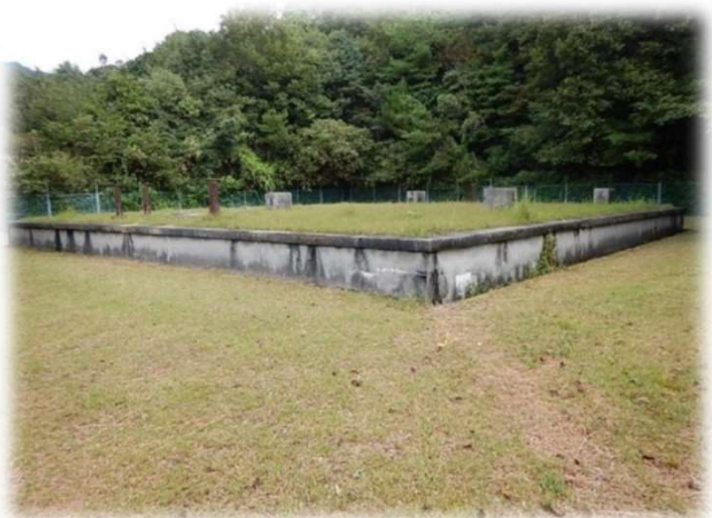
〔一の井手高地区RC配水池〕
