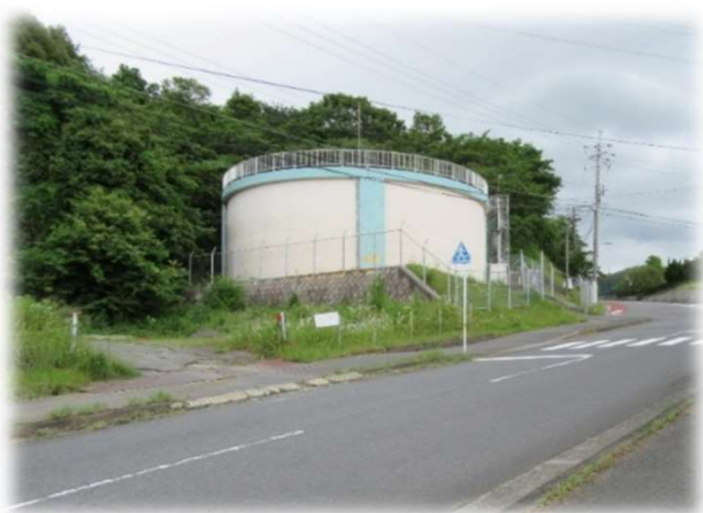
[大迫田東部高地区配水池]
