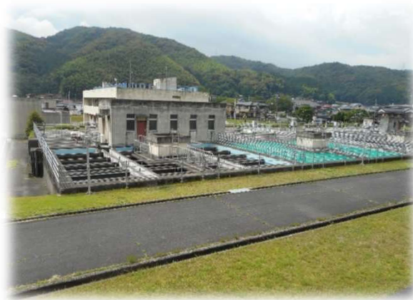
〔高速凝集沈澱池〕
