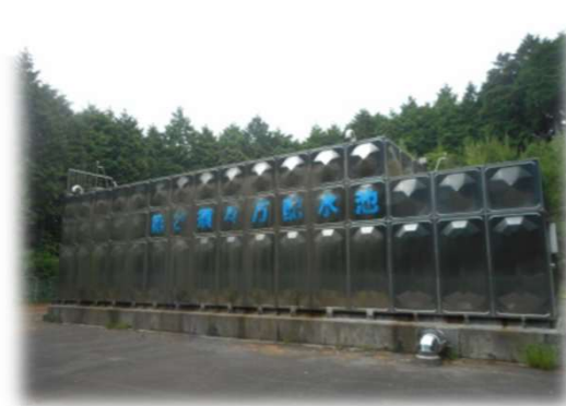
[第2 須々万配水池]
