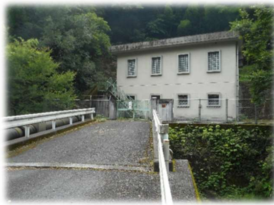
〔中継送水設備（中山中継ポンプ所）〕
