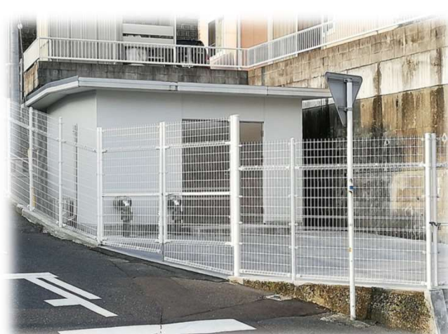
[曙団地ポンプ所]
