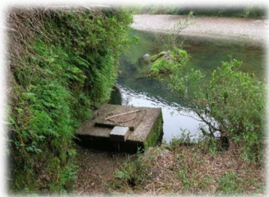
[取水場 (錦川表流水)]
