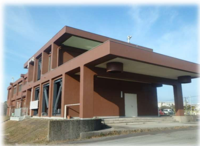
【大迫田浄水場管理棟】
