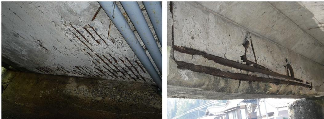
写真2-2 RC床版橋とRC桁橋の剥離・鉄筋露出 ※補修済
