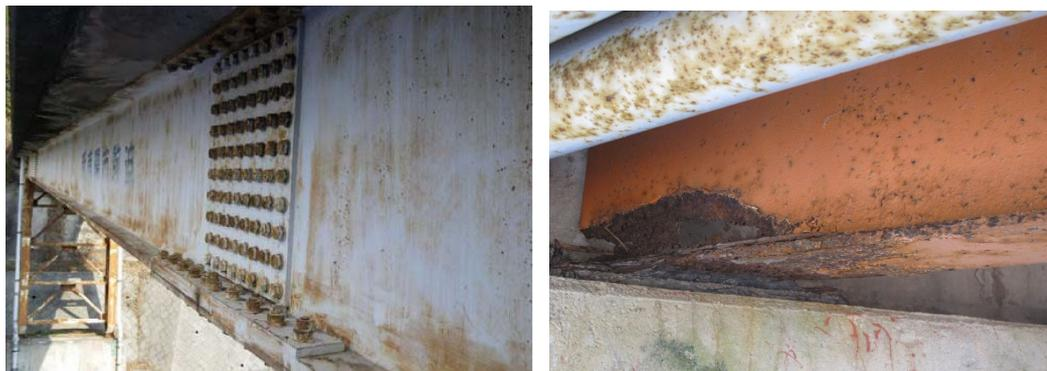
写真2-3 鋼桁の防食機能の劣化と桁端部の孔食 ※補修済
