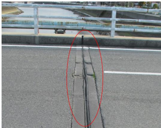
写真2-5 伸縮装置の損傷
