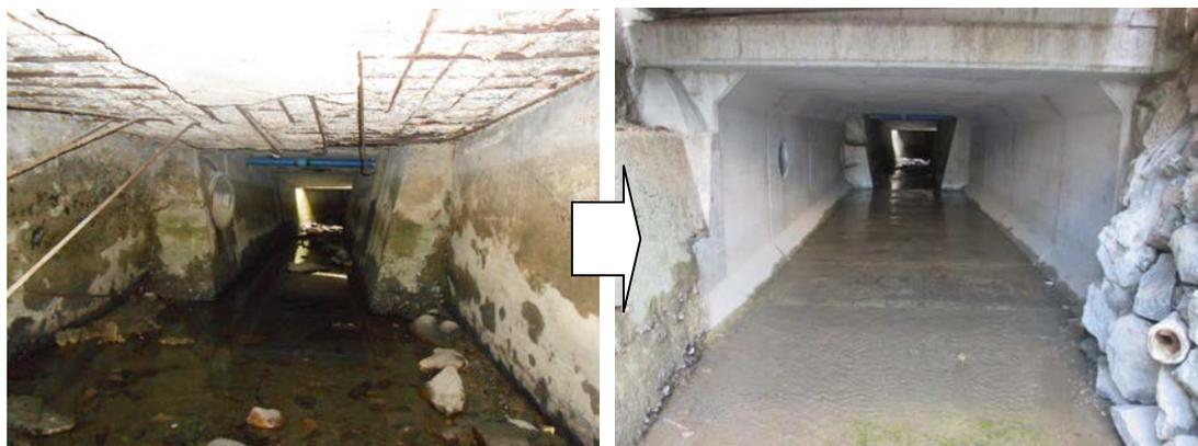
写真3-3 更新(事後保全)の事例 ～ 撤去・更新工
