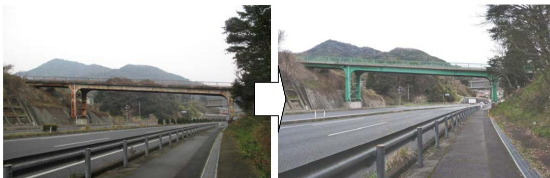
写真3-2 補修(事後保全)の事例 ～ 塗装塗替工
