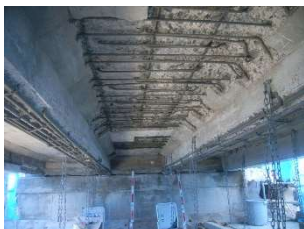
コンクリート橋補修工事
