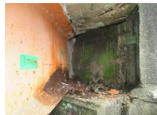
鋼橋補修工事
