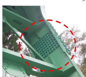
ボルト落下防止対策
