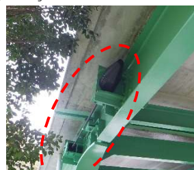
落橋防止対策
