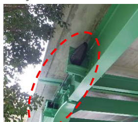
落橋防止対策
