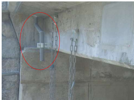
写真2-6 排水対策工
