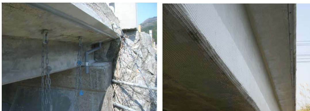
写真3-1 補修(予防保全)の事例 ～ 左：水切り設置工、右：剥落対策工
