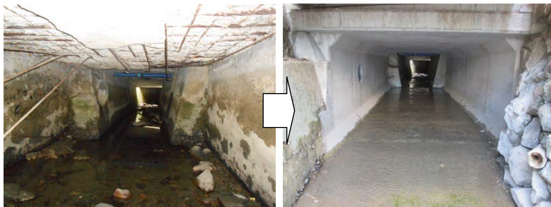
写真3-3 更新(事後保全)の事例 ～ 撤去・更新工
