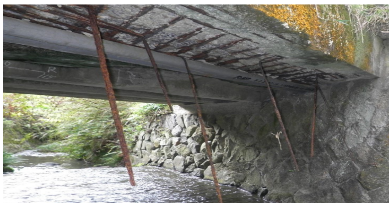
写真2-4 拡幅橋(奥：RC桁橋 手前：RC床版橋) ※補修済
