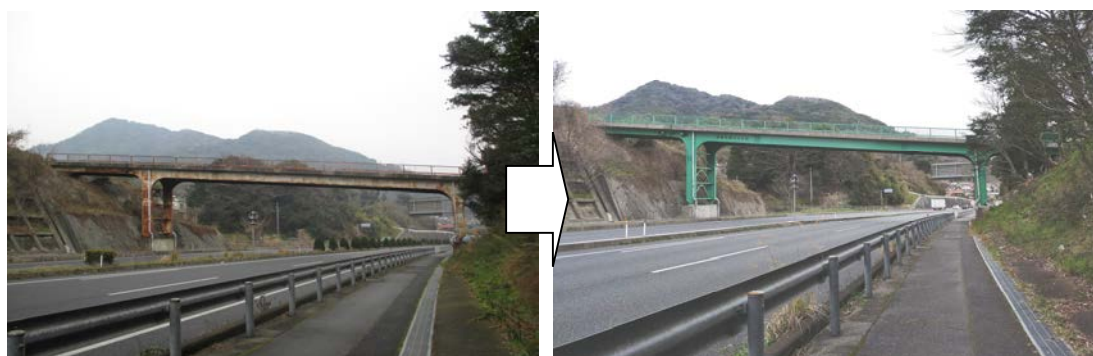
写真3-2 補修(事後保全)の事例 ～ 塗装塗替工
