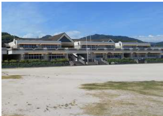
【富田西小(外壁・防水)】
