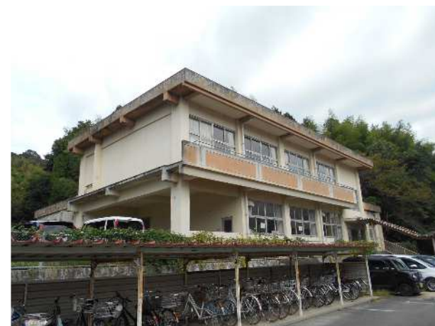
【桜田中(外壁・防水)】
