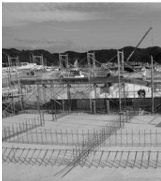
オープンに向けて工事が進んでいます
