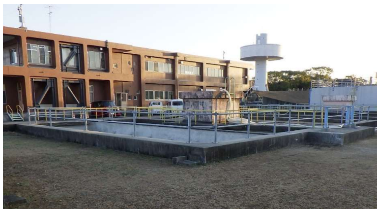
【大迫田浄水場管理棟及び沈殿池】
