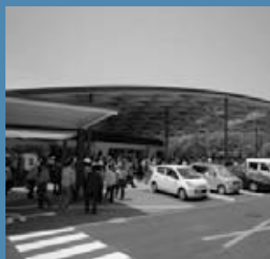
道の駅「ソレーネ周南」の整備
